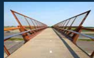
Bicycle bridge Hoofddorp (NL)
